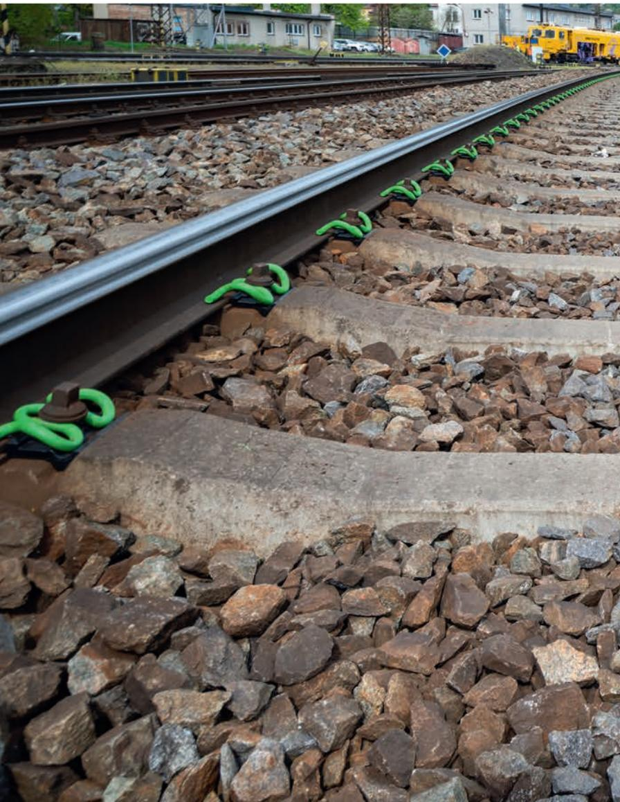
Den Schlüssel zu einer langfristig höheren Gleisverfügbarkeit bietet Vossloh mit seinen physikalisch optimierten Spannklemmen der M-Generation. Ihre innovative Geometrie mit den nach außen gebogenen Federarmen, die zum Schienenfuß einen weiter auseinanderliegenden Kontaktpunkt bieten, und vor allem die S-Kontur machen die M-Spannklemmen robuster gegenüber äußeren Einflüssen, wie z.B. höheren Schienentemperaturen oder Vibrationen infolge von Schienenfehlern.
