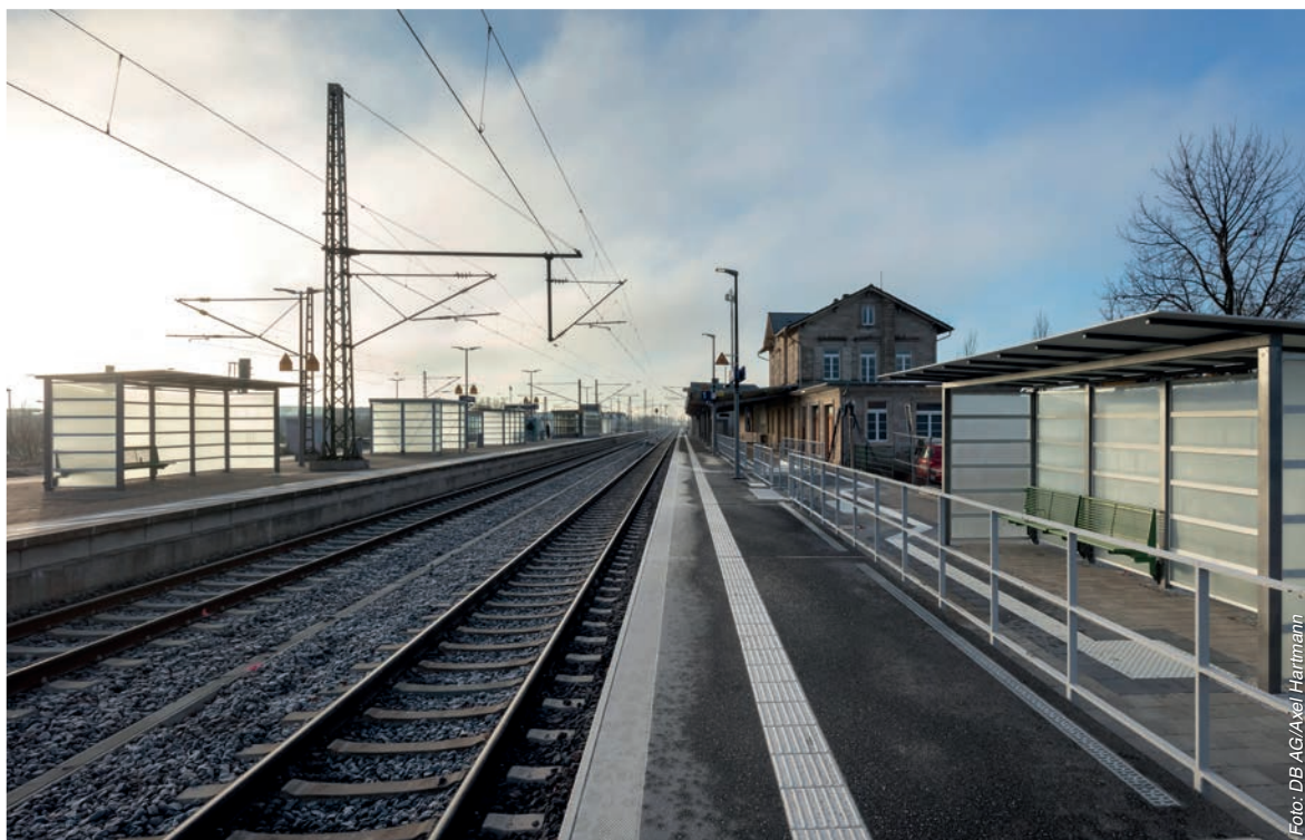
Bahnsteig am Bahnhof Groß-Gerau Dornberg
