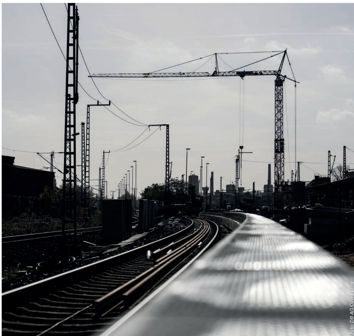
Generalsanierung Hamburg-Berlin: Bauarbeiten an einem neuen Bahnsteig in Wittenberge
