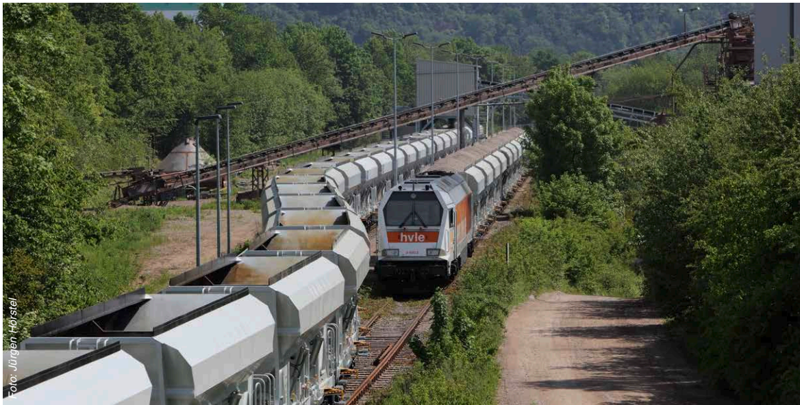
Blick ins Kieswerk von Lammert + Reese in Bodenwerder mit der Verladeanlage, Mai 2019. Erster Einsatz der neuen Faccons-Wagen von GATX. Der Verschub der Wagen im Werk erfolgt mit einem Rangier-Robot von Vollert
