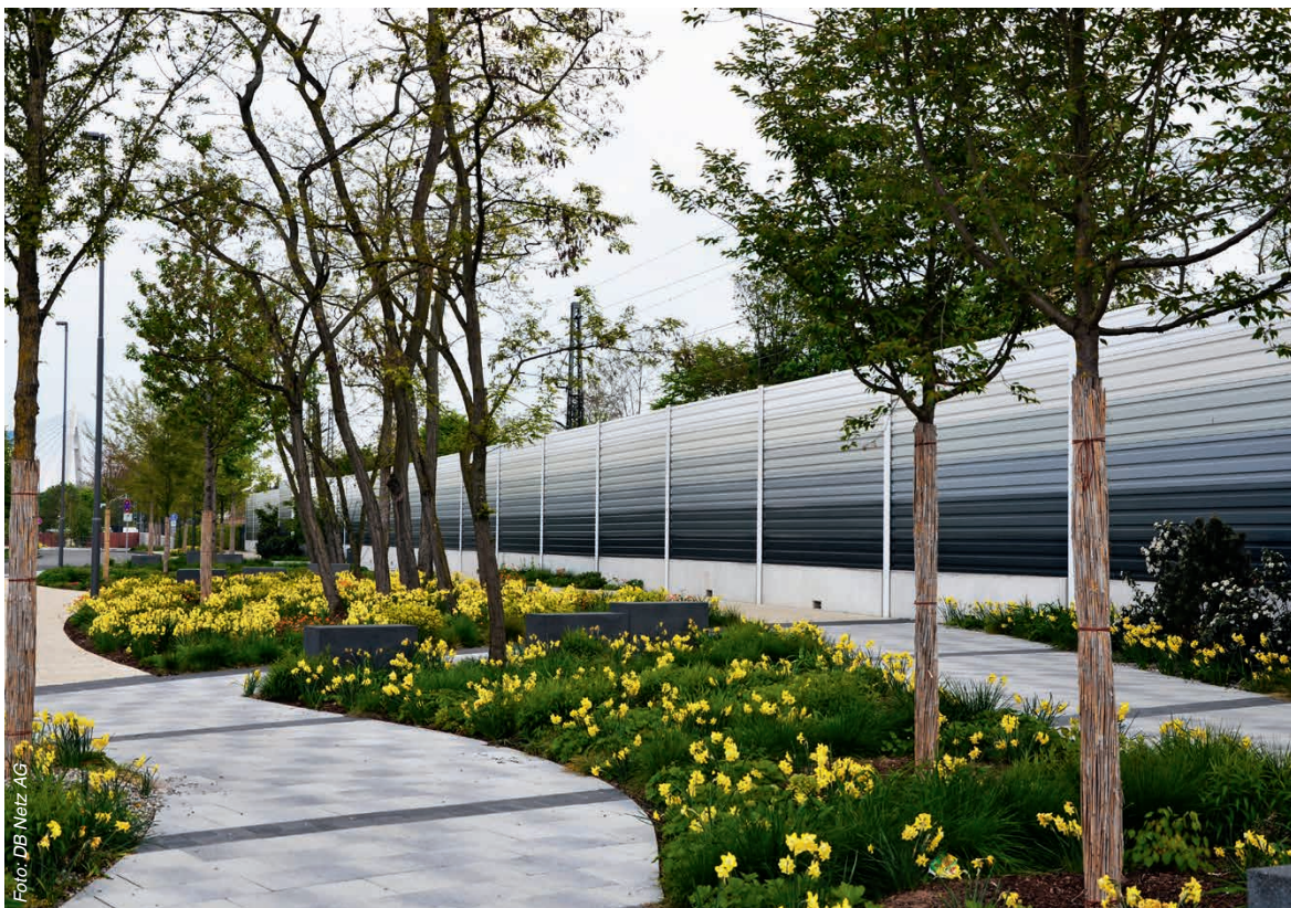
Schallschutzwand in Raunheim, Hessen: Während die Lärmvorsorge durch Maßnahmen an Fahrweg und Fahrzeugen gesetzlich geregelt ist, besteht kein Rechtsanspruch auf Lärmsanierung
