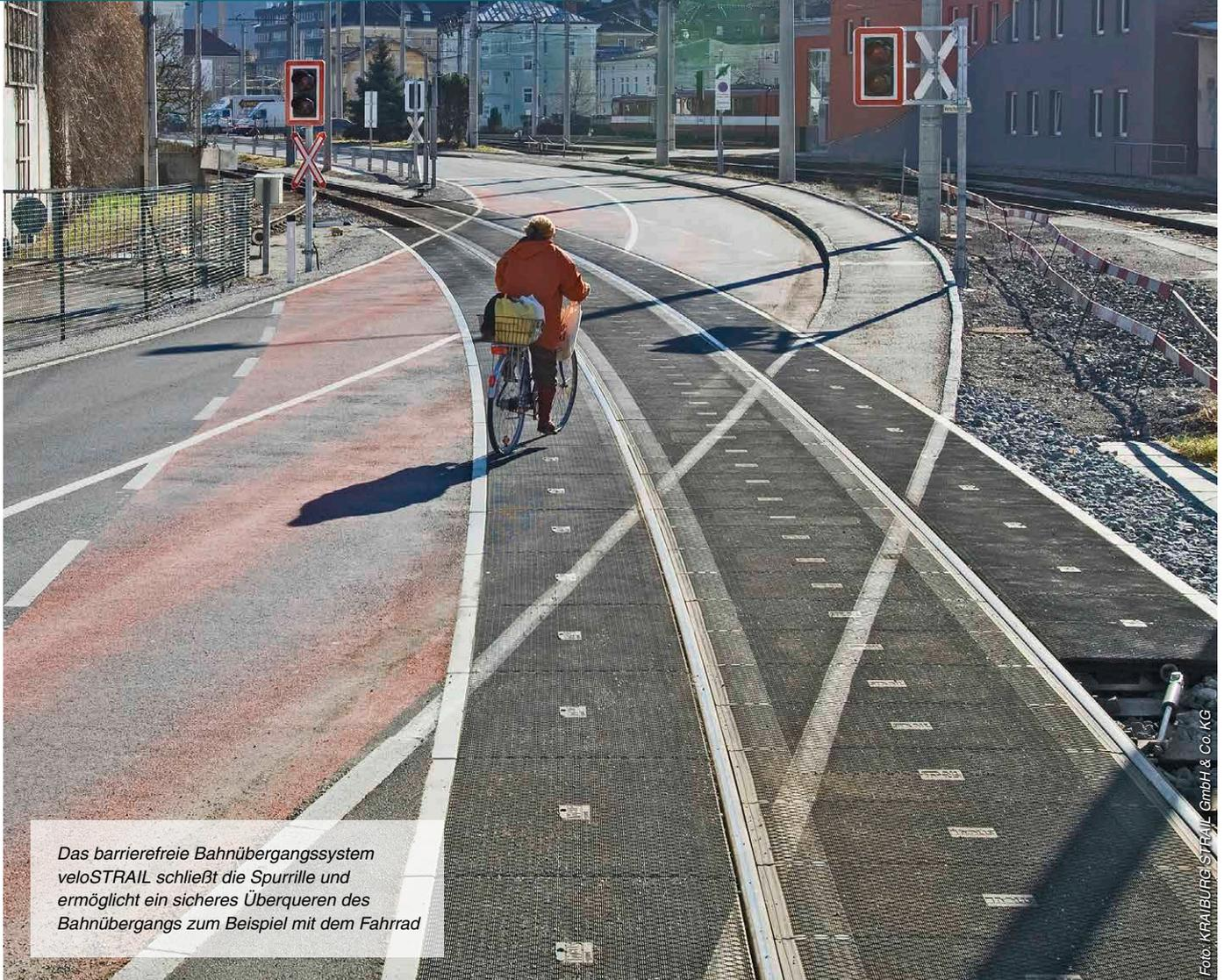
*Das barrierefreie Bahnübergangssystem veloSTRAIL schließt die Spurrille und ermöglicht ein sicheres Überqueren des Bahnübergangs zum Beispiel mit dem Fahrrad*
