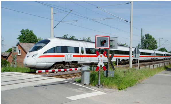
Abb. 4-23: Bahnübergang mit Halbschranke, Andreaskreuz und Blinklichtanlage Foto: DB AG/Günter Jazbec
