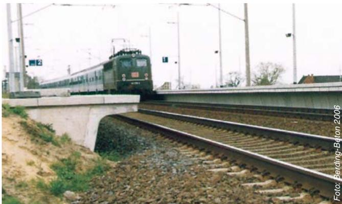
Abbildung 4: Bahnsteig Hp Hagen (Han) mit z-förmigen Kantenelementen
