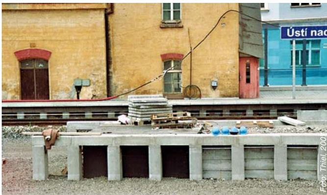
Abbildung 9: Bahnsteigbau mit kleinformatischen Fertigteilen, Bf Ústí nad Labem
