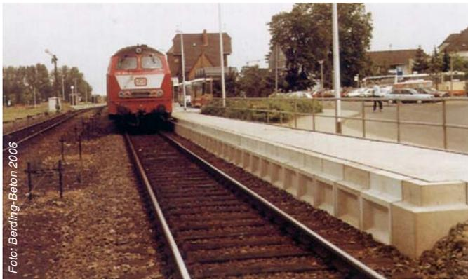
Abbildung 2: Bahnsteig in Erdkernbauweise
