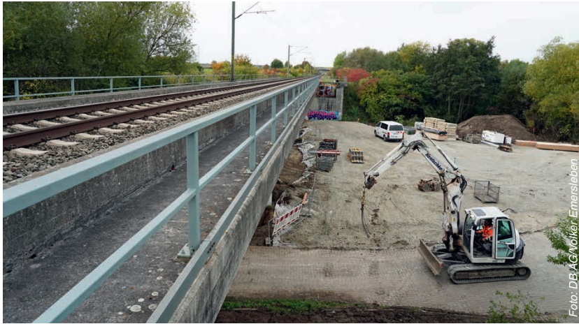
Bau eines zweiten Gleises für die „Weddeler Schleife“: Der Gesetzgeber hat klargestellt, dass alle Vorhaben an Bundesverkehrswegen eine überregionale Bedeutung haben
