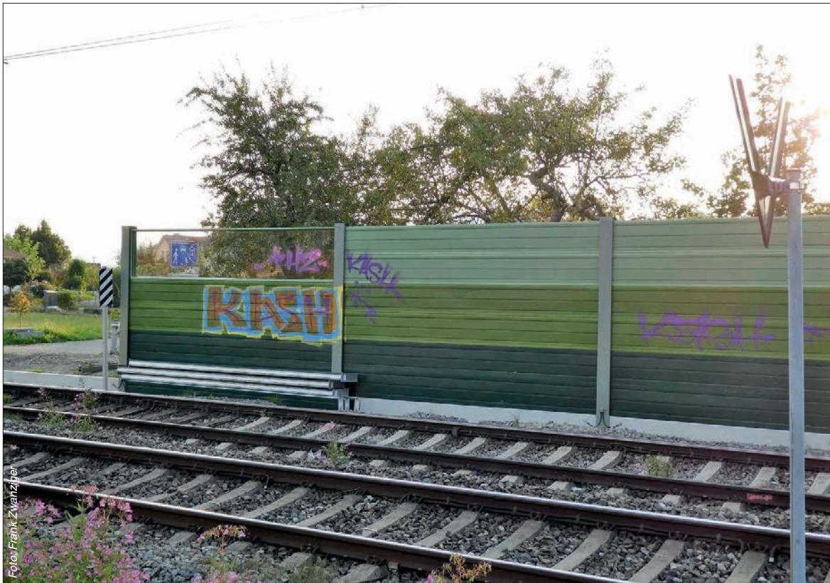
Schallschutzwand (SSW) in Bodolz an der Strecke München–Buchloe–Lindau. Leider sind solche SSW oft Opfer von Graffiti
